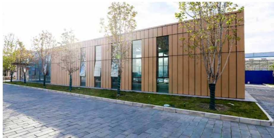
◆ 金风科技北京亦庄智慧园区污水处理系统
