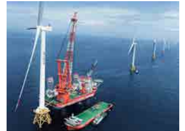
V20 平台國重項目率先號樣機完成吊裝
